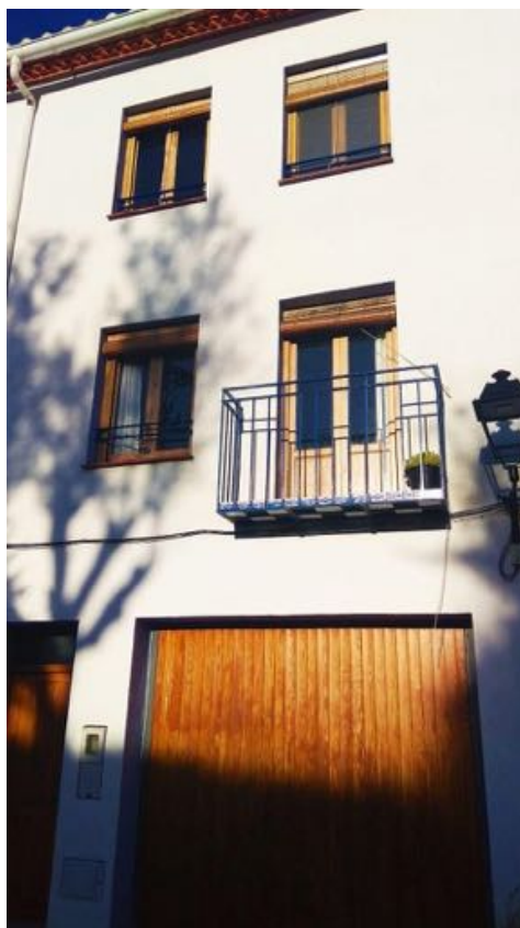
Façana al capvespre, Aín
